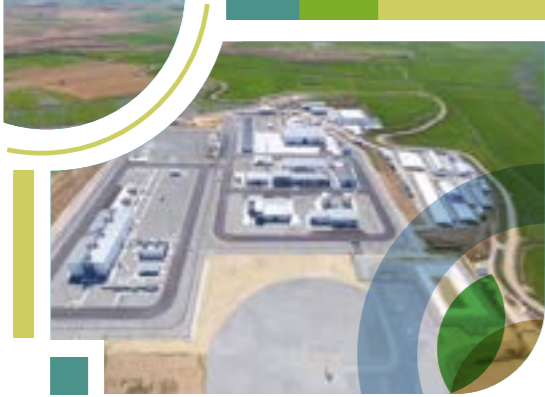
Metering Station (MS-4) Edirne
