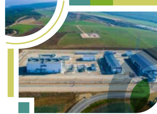
Metering Station (MS-3) Edirne
